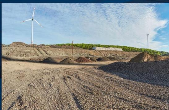
Qu'il s'agisse de ballasts ferroviaires criblés ou d'enrobés goudronneux : il existe une multitude de déchets minéraux qui peuvent être utilisés comme matériau de construction secondaire pour les décharges après un traitement approprié.
