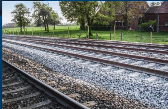
Bei Recyclingschotter handelt es sich um aufbereiteten Alt- bzw. Gleisschotter. Dieser wird sowohl im Gleisbett als auch im Erd-, Straßen- und Deponiebau als hoch-wertiges Baumaterial wiederverwendet.
