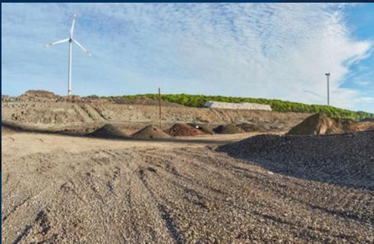
Ob abgesiebter Gleisschotter oder teerhaltiger Straßen-aufbruch: Es gibt eine Vielzahl mineralischer Abfälle, die nach entsprechender Behandlung als Deponieersatzbau-stoff eingesetzt werden können.
