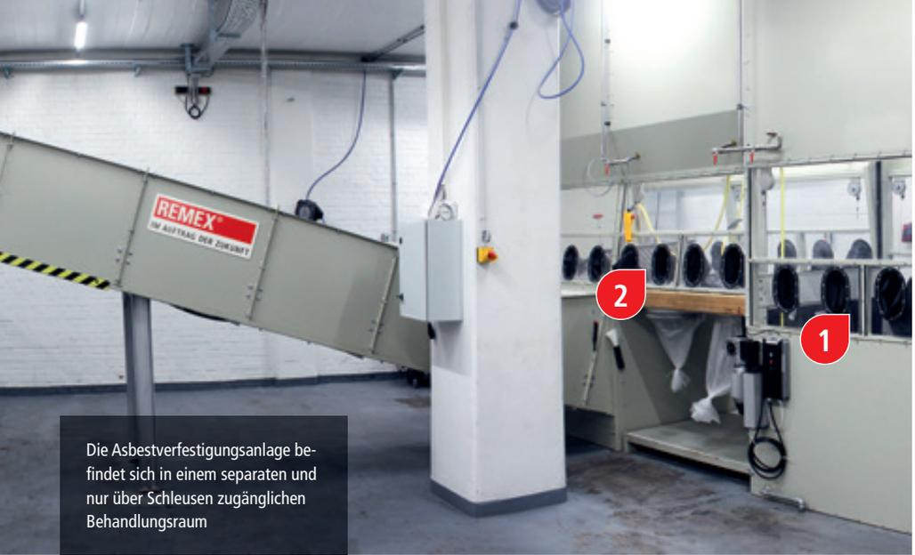
Die Asbestverfestigungsanlage befindet sich in einem separaten und nur über Schleusen zugänglichen Behandlungsraum
