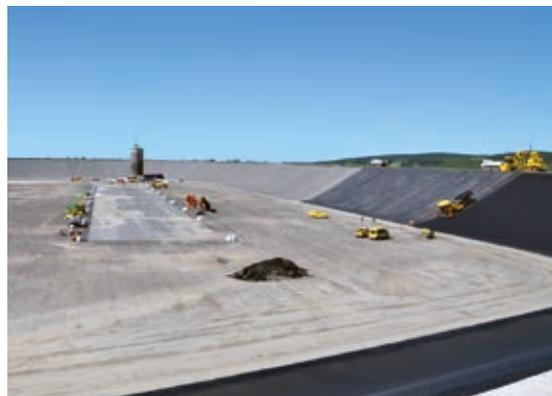
Eine Abdichtung und Erhöhung des Speichers um 70.000 Kubikmeter sollen das Kraftwerk auf die schwankende Stromerzeugung vorbereiten
