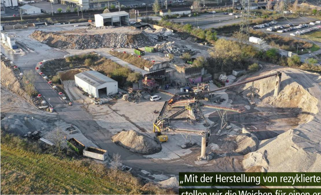
Während des Probelaufs bereitete die REMEX GmbH in Köln rund 500 t Beton-Bauschutt-Gemisch zu Betonrezyklaten auf
