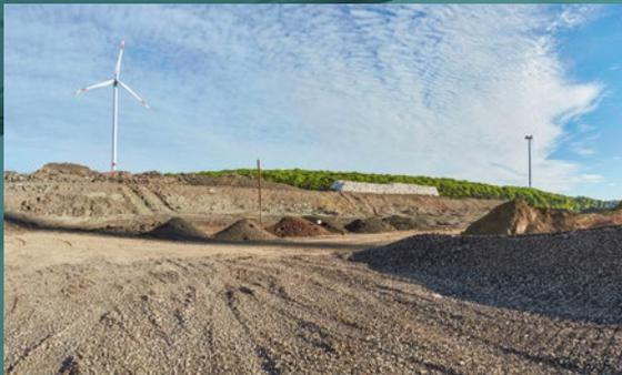
Ob abgesiebter Gleisschotter oder teerhaltiger Straßenaufbruch: Es gibt eine Vielzahl mineralischer Abfälle, die nach entsprechender Behandlung als Deponieersatzbaustoff eingesetzt werden können.
