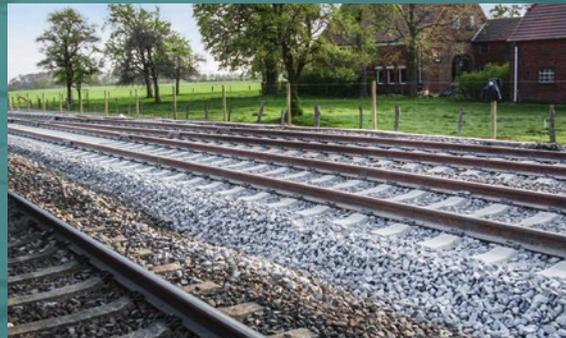
Bei Recyclingschotter handelt es sich um aufbereiteten Alt- bzw. Gleisschotter. Dieser wird sowohl im Gleisbett als auch im Erd-, Straßen- und Deponiebau als hochwertiges Baumaterial wiederverwendet.
